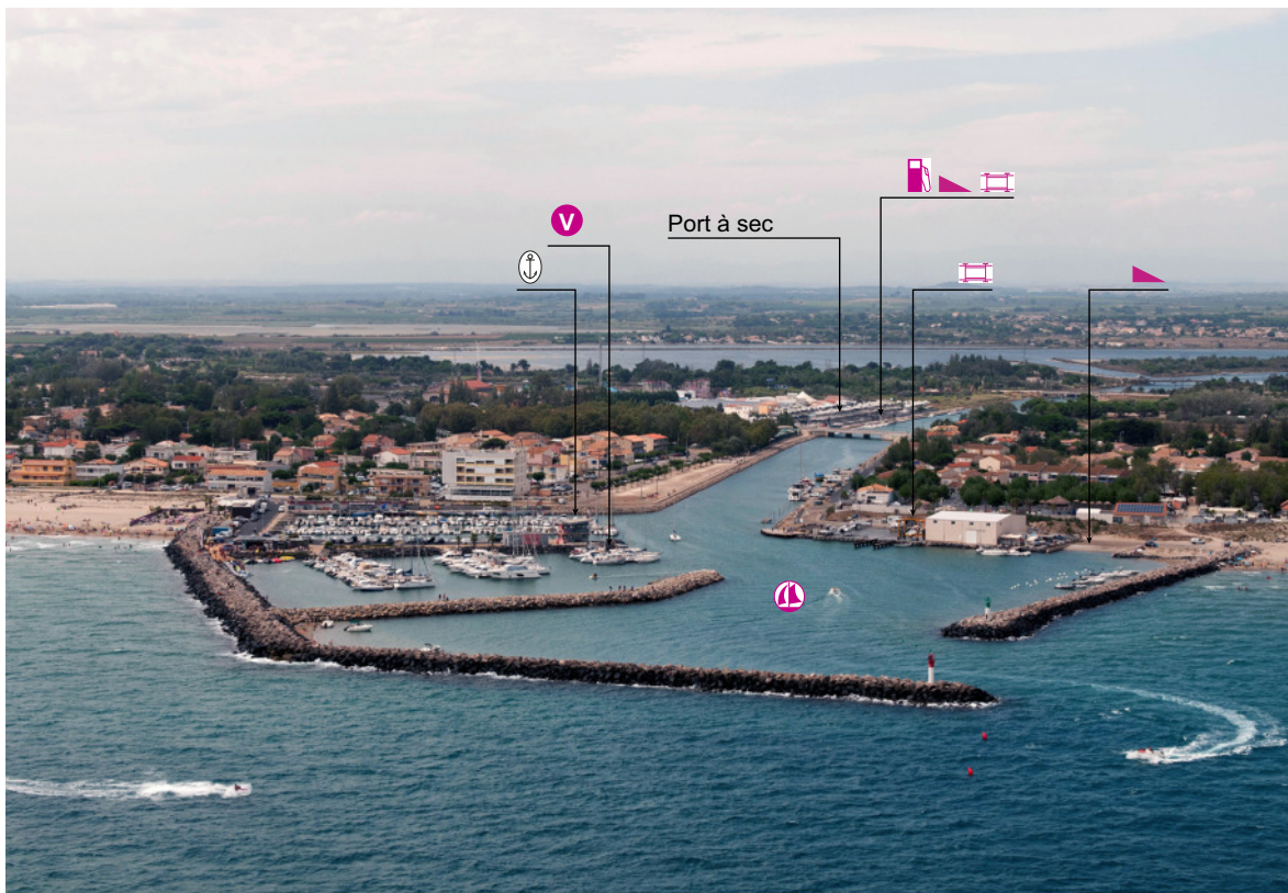
3.2.2. — Port de Marseillan-Plage. Vue générale, au NW (2020).
