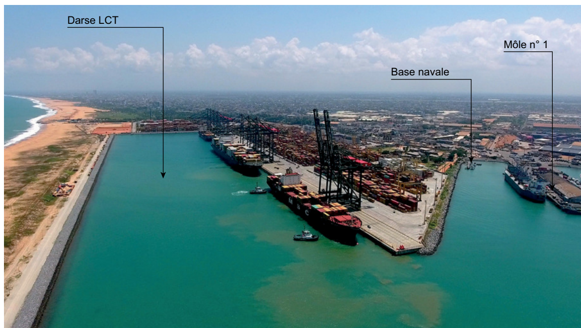
3.2.1.1.B. — Vue aérienne de la darse LCT, à l'Ouest [2022] (Port autonome de Lomé).
