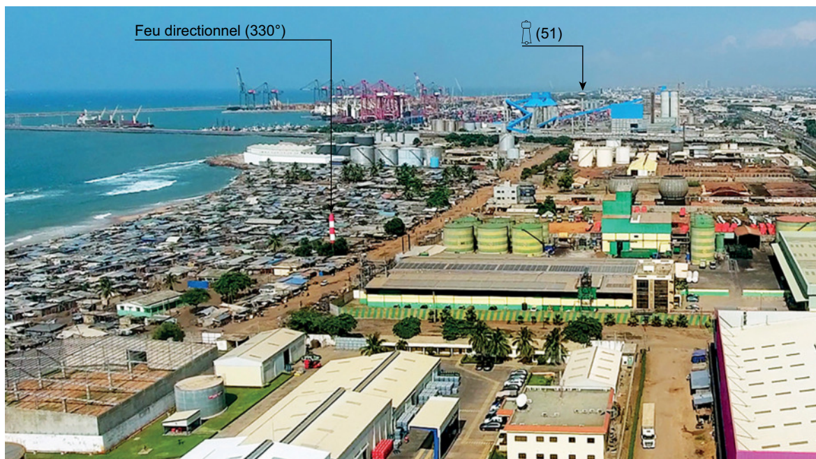
3.2.1.5. — Vue aérienne de la zone industrielle du port de Lomé, à l'Ouest [2022] (Port autonome de Lomé).
