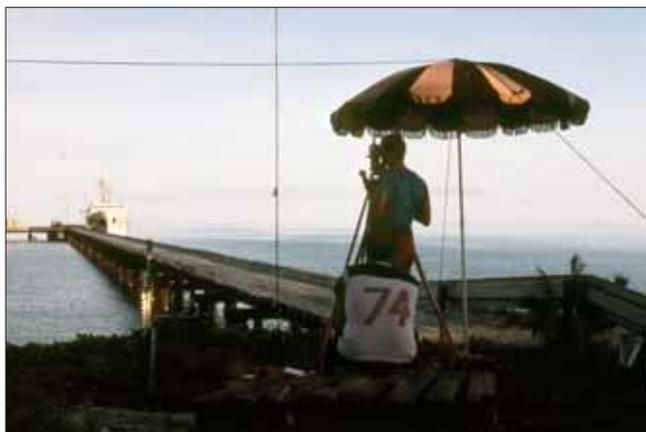
*Station de guidage optique au wharf de Wadrilla
