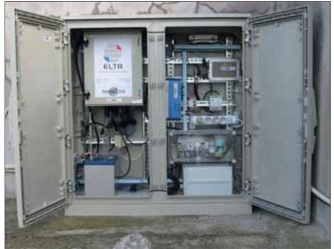
*Centrale d'acquisition, transmissions temps réel et batteries à Solenzara*
