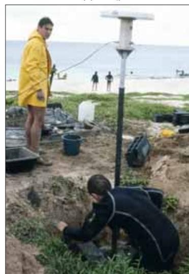
Construction d'une stèle autour du tube métallique supportant l'antenne du récepteur JMR 4
