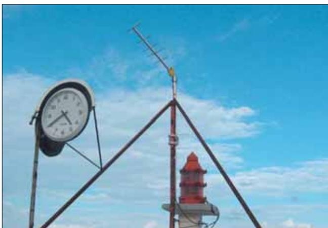
Fig.13 : Antenne de transmission vers Météosat-9 installée sur le site du MCN de Dzaoudzi (Mayotte)
