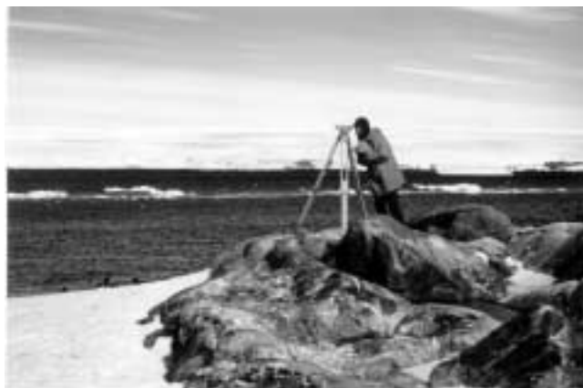
Travaux de nivellement sur l'Île des Pétrils
