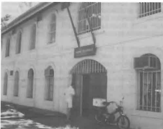
Façade de l'immeuble Bir Hakeim, sur le front de mer à Papeete
