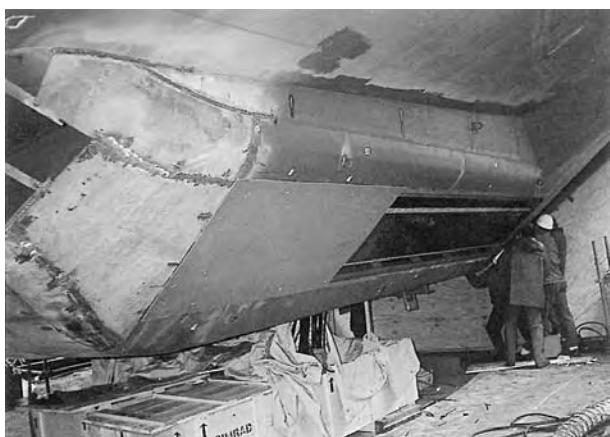
« Installation des transducteurs du sondeur multifaisceaux SIMRAD EM 12 DUAL sur la coque du BH1 L'Espérance »
