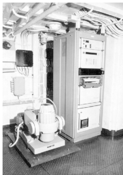
Gravimètre KSS 31 de Bodenseewerk.
