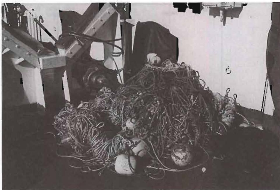
Photo 14. Les bouts récupérés dans les hélices après les sondages au sud de la Grande-Terre (Guadeloupe)
