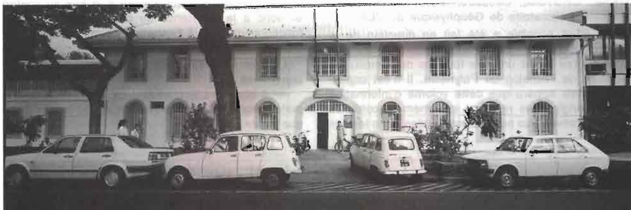
Locaux à terre de la MOP à Papeete.
